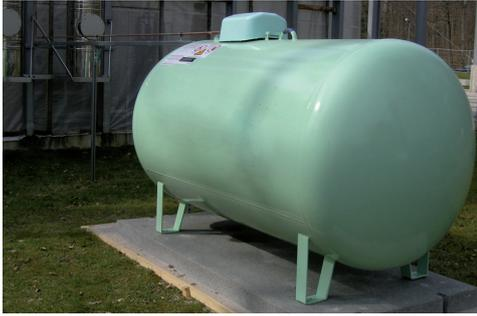
Abbildung 2.7: Flüssiggastank zur Versorgung der Heizgeräte während den Untersuchungen
